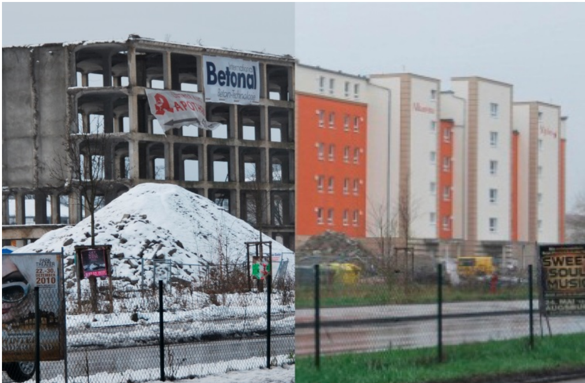
Abb. 8: Auch wenn das alte Gebäude nur teilweise erhalten bleibt, lässt sich nachhaltig Bauschutt vermeiden: Um die bewahrten Stahlskelettstruktur eines Kasernenbaus herum (Bild links) entstand ein modernes Heim für betreutes Wohnen (Bild rechts).
